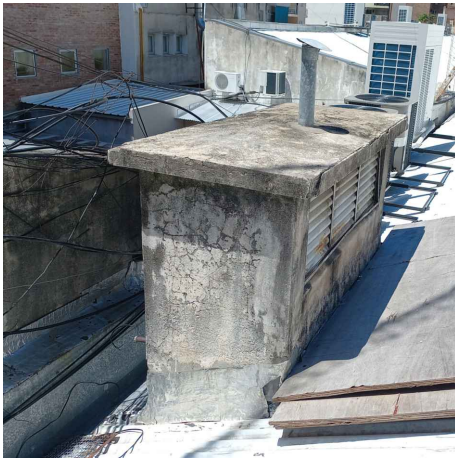
FILTRACIONES ALREDEDOR DE LA CASETA DE VENTILACION SOBRE CALEFACCION CENTRAL
