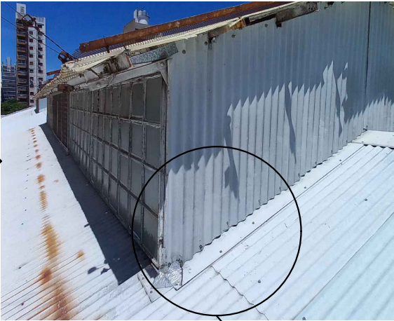
FILTRACIONES EN EL ENCUENTRO LATERAL DEL FALDON CON LA PARED
