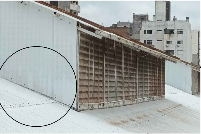
FILTRACIONES EN LA CARA SUR DE LOS LUCERNARIOS
